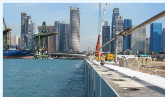
Prefabrykat - Singapur falochrony brzegowe portu
