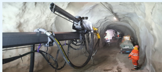
Torkretowanie - tunel Barmasse
