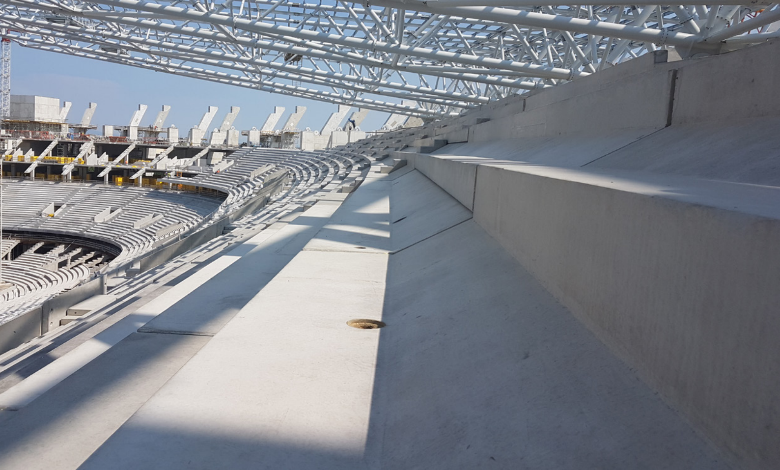
Prefabrykowane elementy trybun, budowa stadionów
