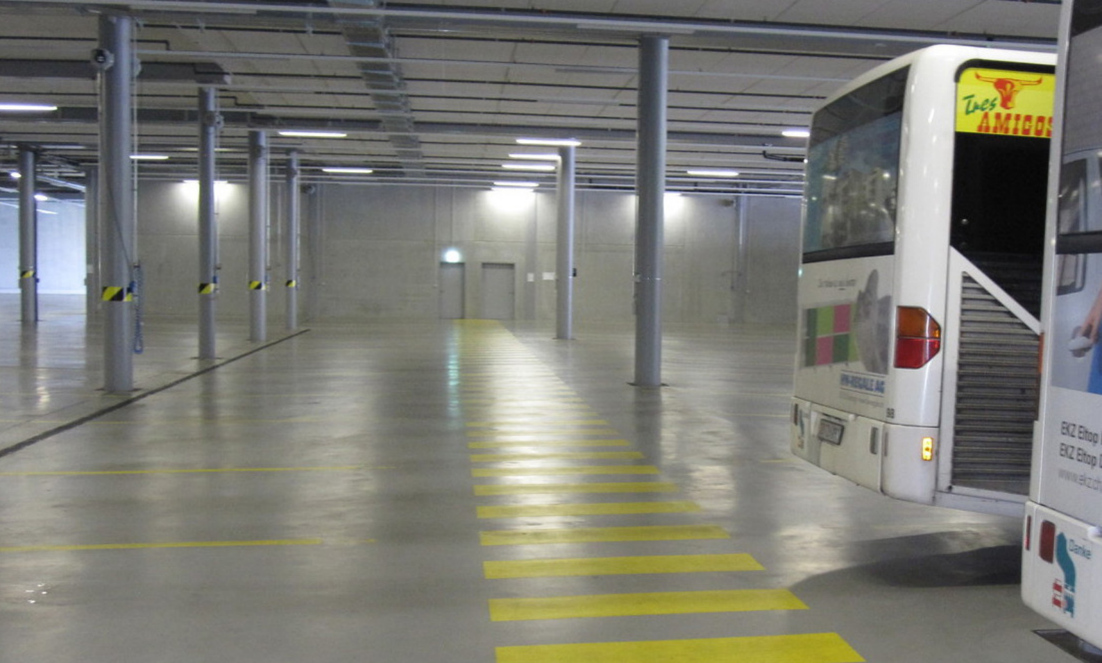
Terminal autobusowy w Szwajcarii, posadzki zbrojone włóknem Fibrofor High Grade dozowanego w ilości 1 kg/m 3 betonu
