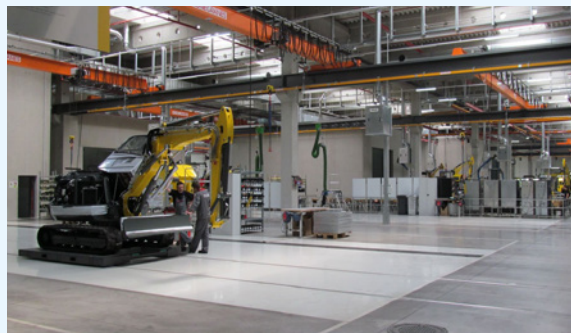
Bezspoinowa posadzka przemysłowa - Fibrofor High Grade
