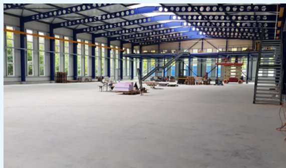
Bezspoinowa posadzka przemysłowa - Fibrofor High Grade
