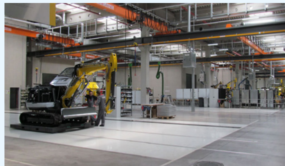
Bezspoinowa posadzka przemysłowa - Fibrofor High Grade
