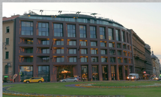
Elementy prefabrykowane - Fasada budynku
