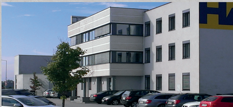
Prefabrykowana fasada budynku
