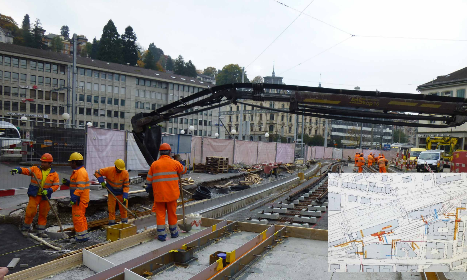
Nawierzchnia betonowa stacji w St. Gallen (Switzerland)
