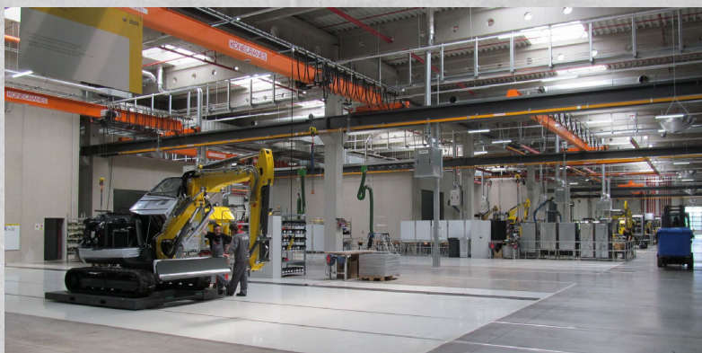
Bezspoinowa płyta betonowa przemysłowa o powierzchni 50 000 m 2 zbrojona wyłącznie włóknem Fibrofor High Grade
