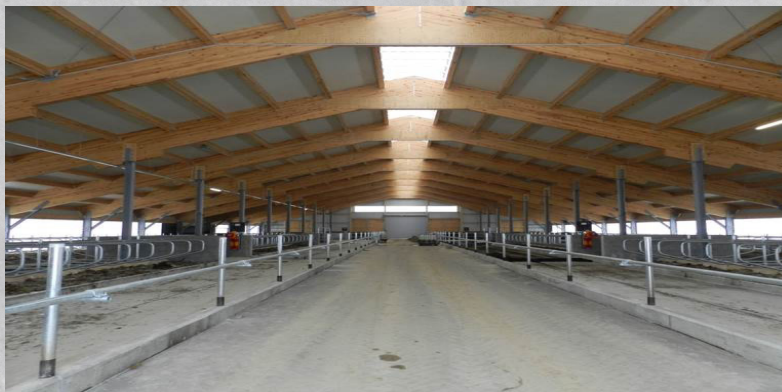
Obora (beton odporny na działanie odchodów) beton bez ryzyka zranienia zwierząt
